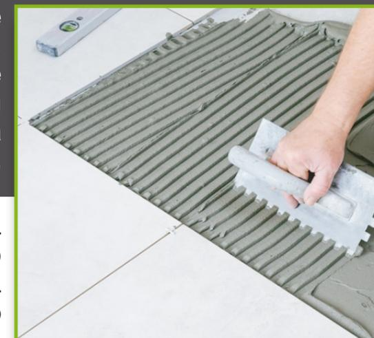
1. **Técnica del doble encolado:** para la colocación del adhesivo a la pieza y adhesivo al soporte. Así se mejora la humectación de la baldosa favoreciendo un contacto homogéneo en la totalidad de la superficie del reverso de la
